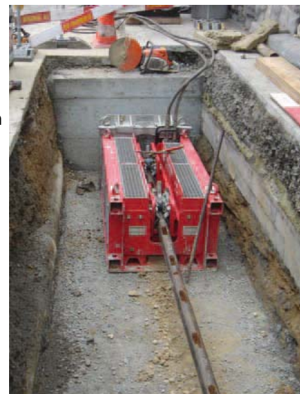
Hydraulische unit in de startput
